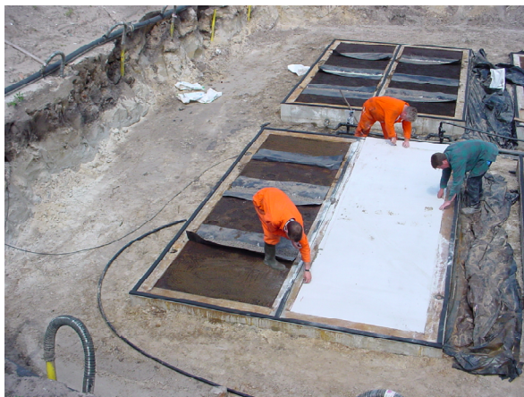
Fig. 39. Afsluiten van de bakken met bentoniet en afneembare deksels.
