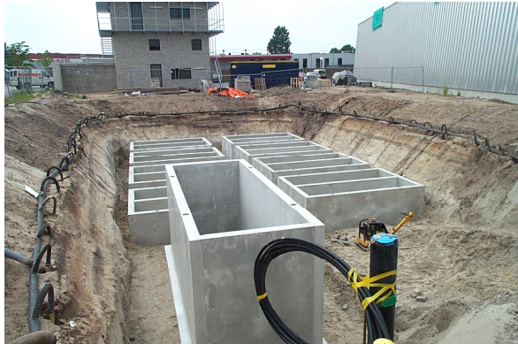
Fig. 38. Aanbrengen van de bakken en vullen met ijzer.
