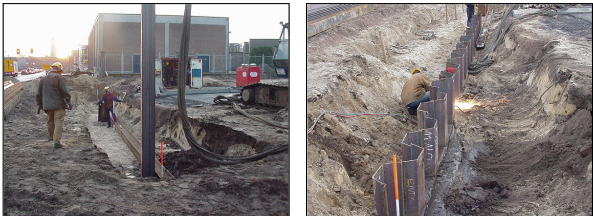
Fig. 33. Aanbrengen damwand langs de Amsterdamseweg.
