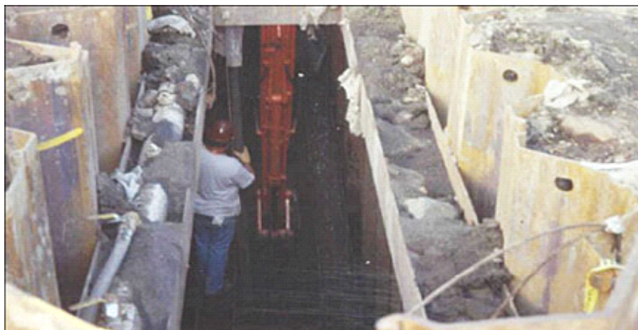
Fig. 6. Aanleg van een verticale sleuf.
