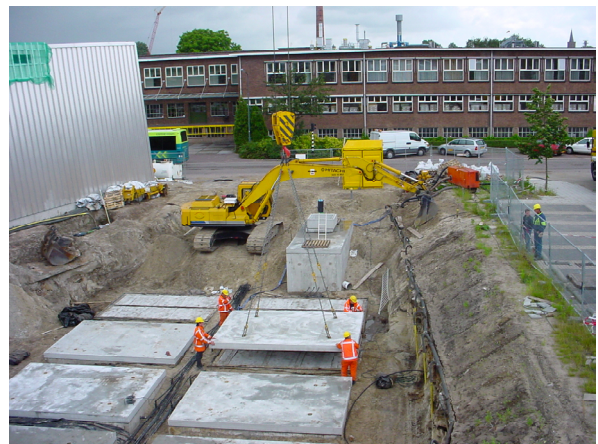
Fig. 39. Afsluiten van de bakken met bentoniet en afneembare deksels.
