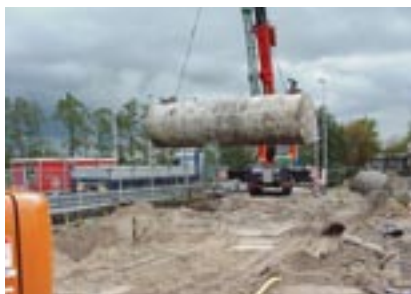
Verwijdering ondergrondse tank (bron Tauw)
