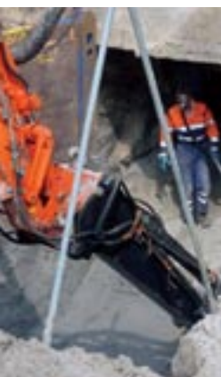
Persoonlijke bescherming tegen blootstelling door uitdamping tijdens ontgraving.
