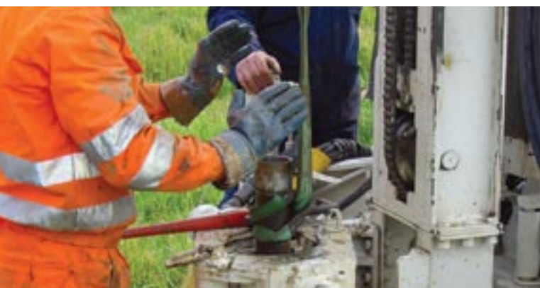
Uitvoeren mechanische boring voor plaatsing peilbuizen (bron Tauw)
