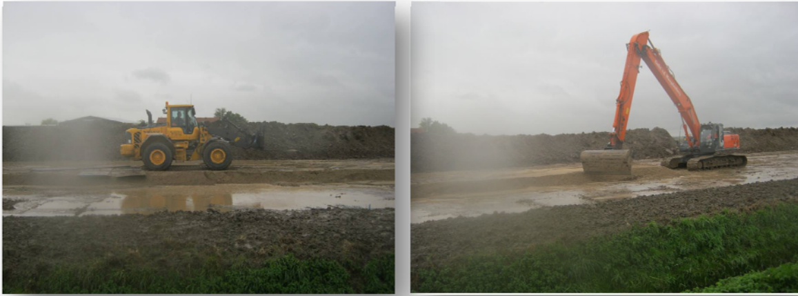
Fig. 4.1. De aanleg van een rijbaan door zand en rijplaten nadat de teelaarde is afgegraven
