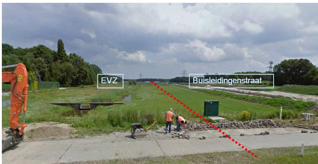
Afbeelding 1 Een ecologische verbinding op de grens van de buisleidingenstraat
