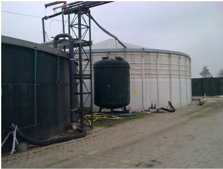
Figuur 6 Opslagtank voor varkensdrijfmest bij een mestverwerkende installatie.
