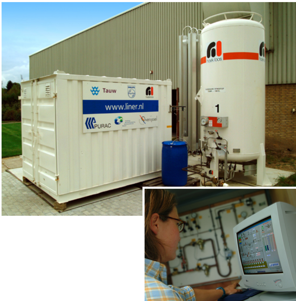
Fig. 1. Bovengrondse installatie van LINER®.
