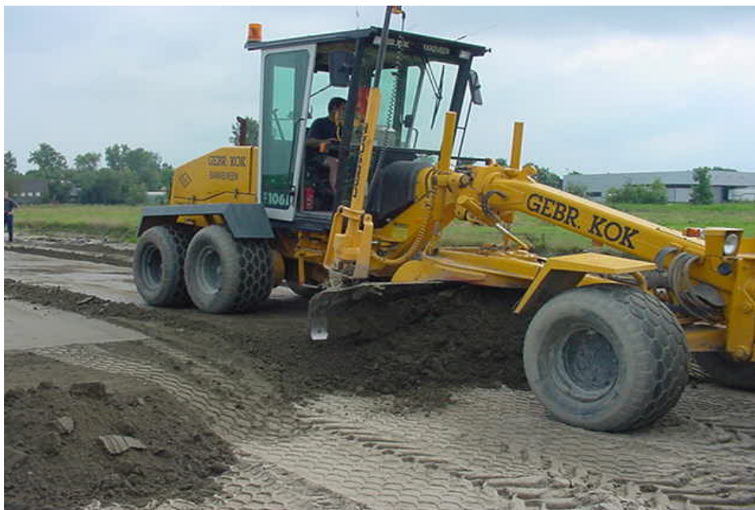
Fig. 5 Egaliseren van immobilisatieproduct m.b.v. grader.
