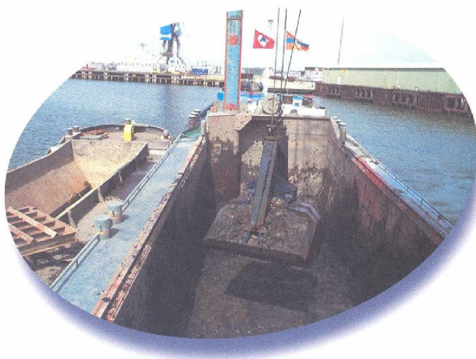
Fig. 5. Opbaggeren van baggerslib uit de Rotterdamse haven.
