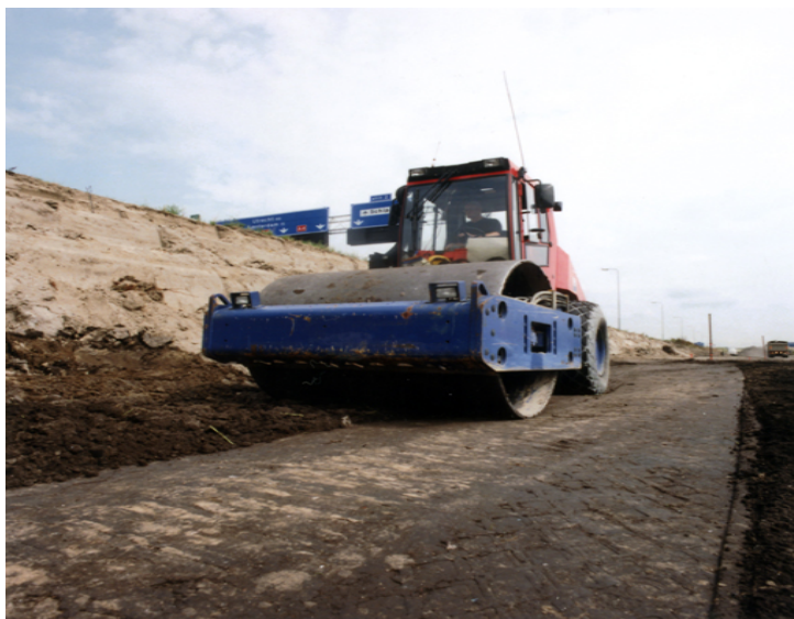
Fig. 8. Aanleg proefophoging met gerijpte baggerspecie in de A5 bij Badhoevedorp. Het verdichten van de kleiige baggerspecie. Foto: DWW.
