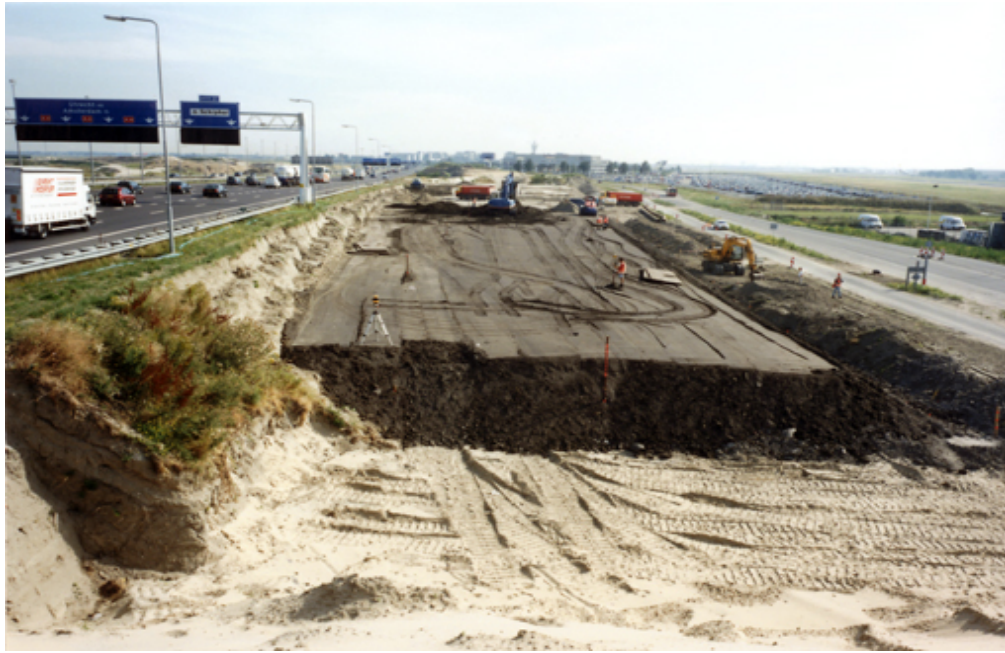
Fig. 7. Aanleg proefophoging met gerijpte baggerspecie in de A5 bij Badhoevedorp. Lengte 125 m, breedte gemiddeld 20 m, hoogte 4 m. Foto: DWW.
