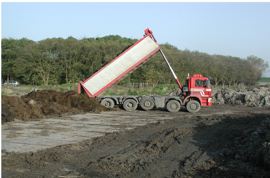
Fig. 6. Aanvoer maaisel Enkhuizen. Foto: HHNK.
