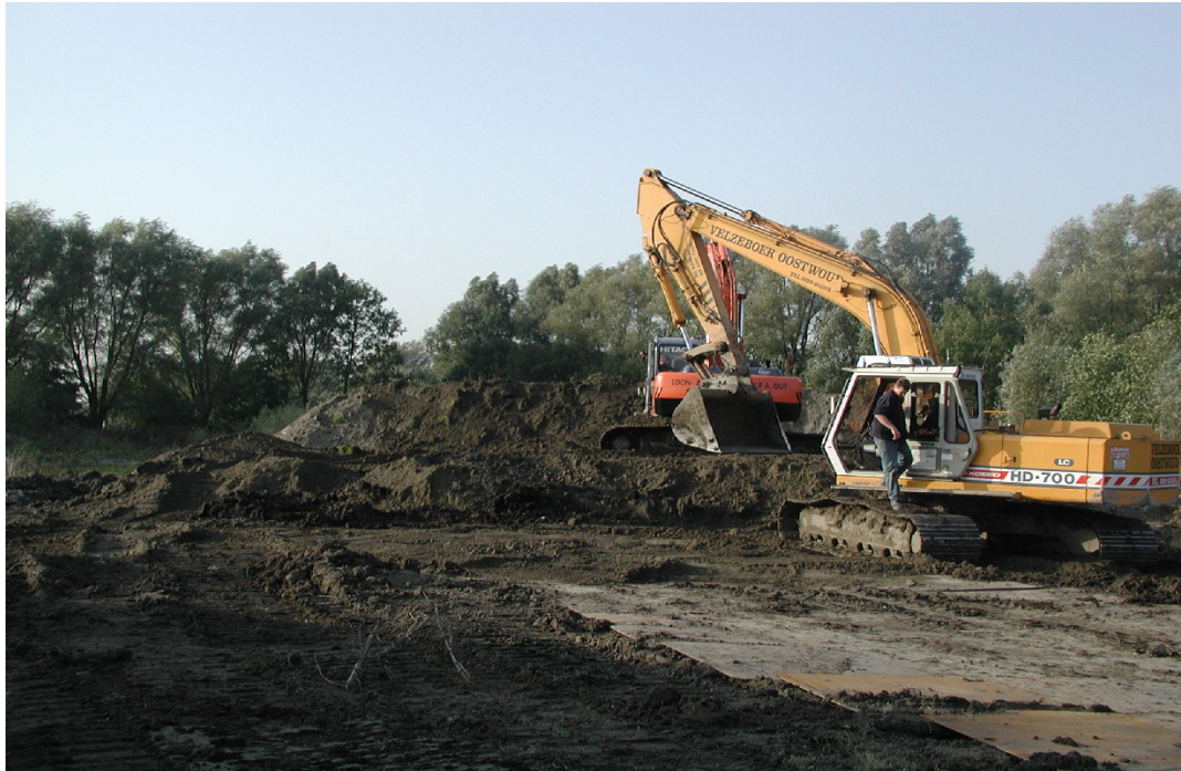
Fig. 5. Aanleg ophoging Enkhuizen. Foto: HHNK.
