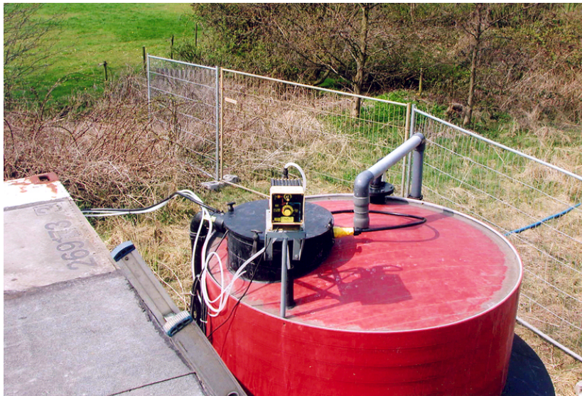
Fig. 5. Doseervat en doseerpomp voor de nitraatoplossing.
