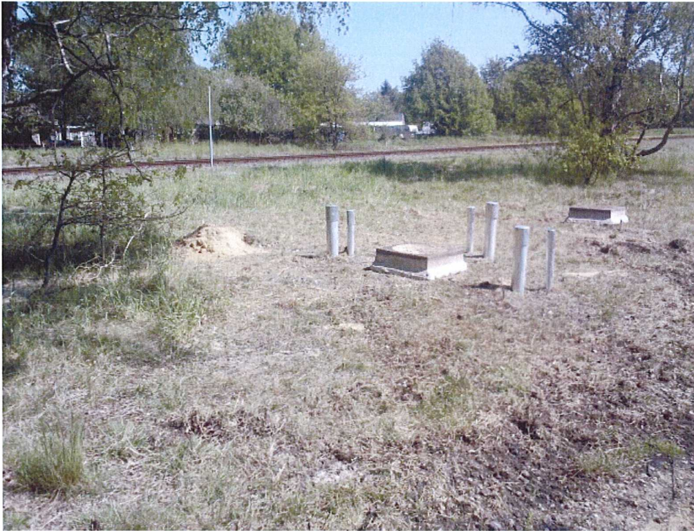
Figuur 3.3 Overzichtsfoto op 9 mei 2008. Beide injectoren zijn geplaatst en afgedekt met een betonnen putdeksel. Ook is al een deel van het monitoringstelsel rond injector 3000 geplaatst. Foto is genomen kijkend naar het noordoosten, richting Budel-Schoot. De spoorlijn is eveneens zichtbaar (© Tauw, 2008)
