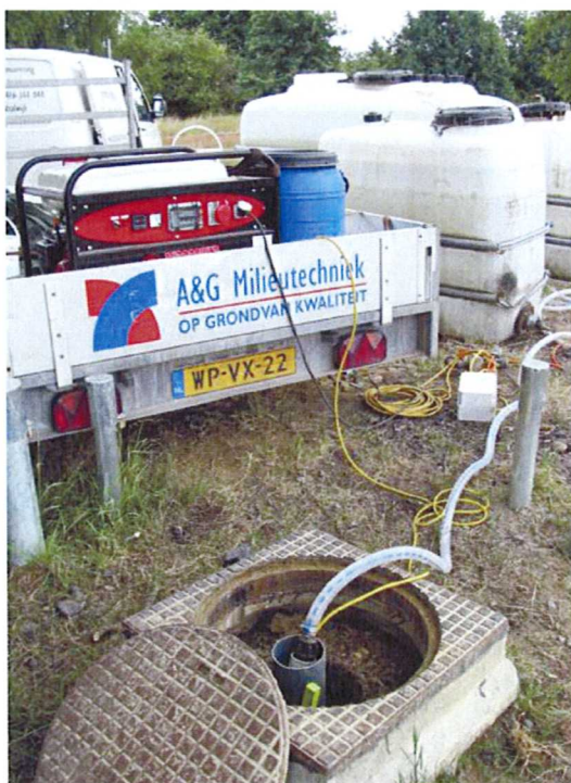
Figuur 6.1 Onttrekken van grondwater door A&G Milieutechniek. Onttrokken grondwater wordt eerst verzameld in een 3 m 3 container. Op de voorgrond is injector 3000 zichtbaar (© Tauw, 2008)
