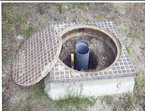
Figuur 3.4 Detailfoto van injector 3000 (© Tauw, 2008)
