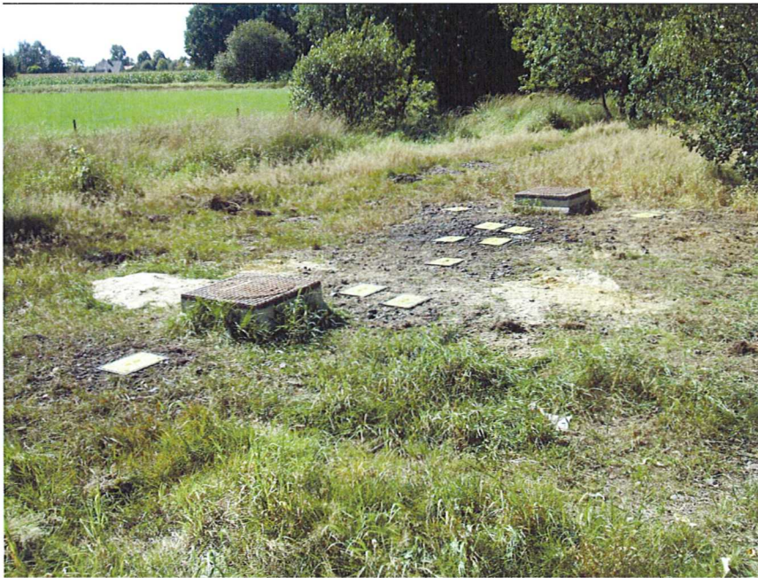
Figuur 3.6 Het injectie- en monitoringssyteem op 10 september 2008 nadat de herstelwerkzaamheden waren uitgevoerd. De foto is genomen vanuit het noordoosten, niet zichtbaar is de referentiepeilbuis 3008. Vergelijk ook met de lay-out van het syteem in figuur 3.2 en 3.5 (© Tauw, 2008)
