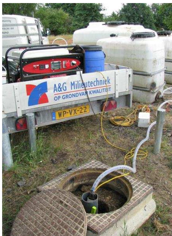
Figuur 6.1 Onttrekken van grondwater door A&G Milieutechniek. Onttrokken grondwater wordt eerst verzameld in een 3 m 3 container. Op de voorgrond is injector 3000 zichtbaar
