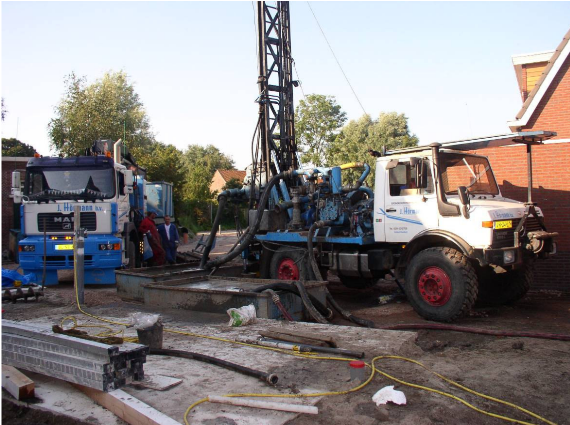
Figuur 5.6: Plaatsing permanente filters
