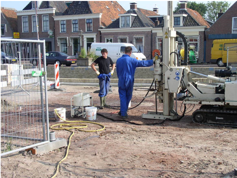
Figuur 5.2: Injectie-opstelling
