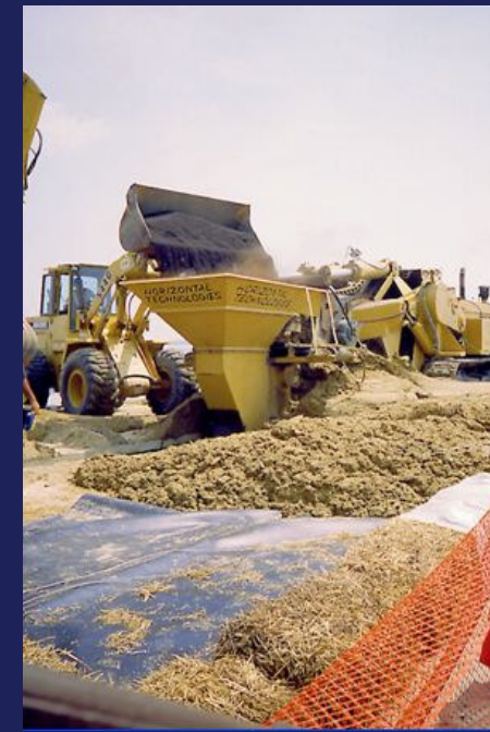
Vullen met 125 ton granulair ijzer
