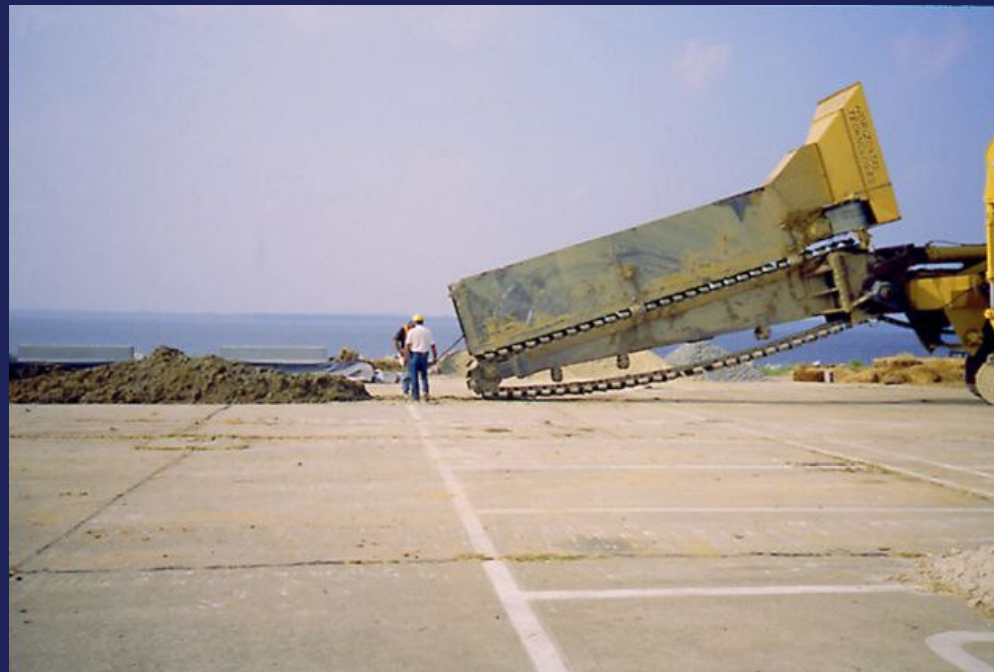
Sleuf graven met kettinggraver (30 cm)
