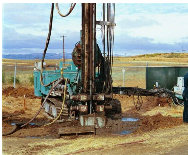
Figuur 6.2 Ijzerscherm aanbrengen door injectie met een jetsysteem (Bron: ETI)
