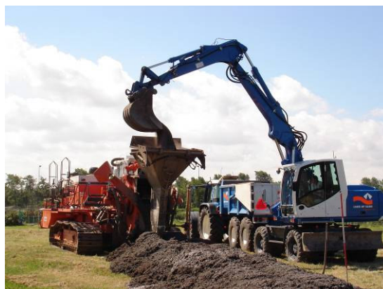
Figuur 4.6 Vullen met ijzer/zand mengsel
