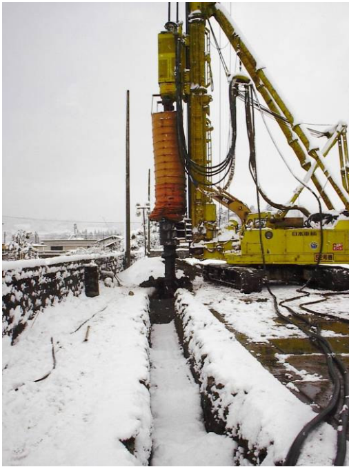
Figuur 6.3 IJzerscherm aanbrengen met avegaarboringen tot 17 m Japan 2002 (Bron: ETI)
