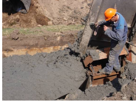
Figuur 4.10 aanbrengen foliescherm
