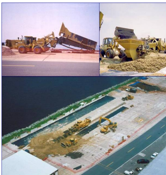
Figuur 3.2 Aanleg ijzerscherm in de VS
