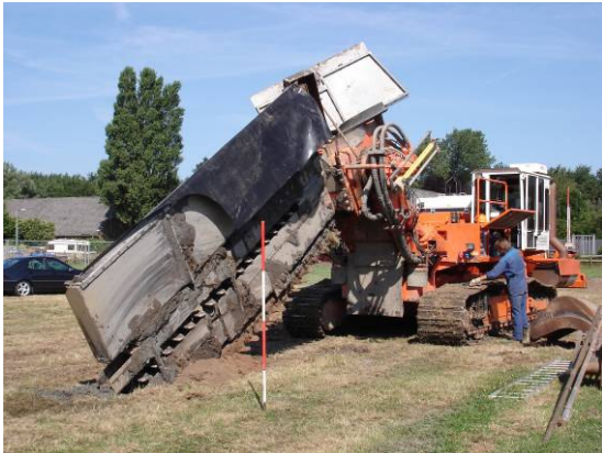
Figuur 4.9 Kettinggraver met folie in cassette
