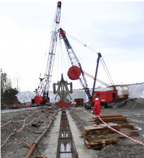
Figuur 6.4 IJzerscherm aanbrengen met diepwandtechnieken Turijn 2004 (Bron: ETI en NTP Milieu)
