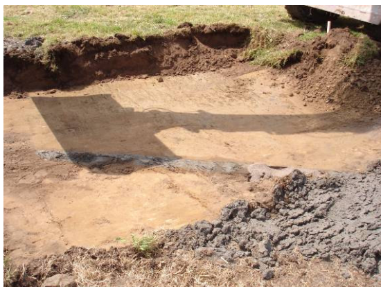
Figuur 4.7 Vrijgraven ijzerscherm
