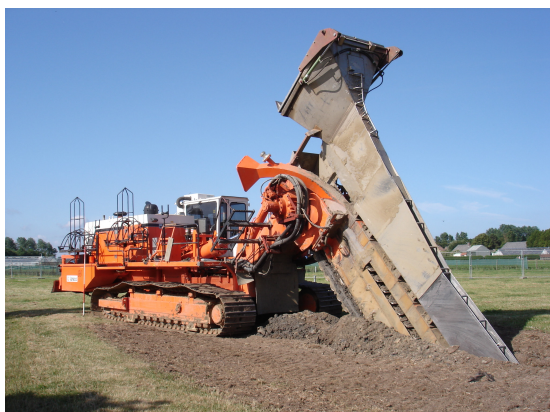
Figuur 4.5 Aanleg ijzerscherm met kettinggraver
