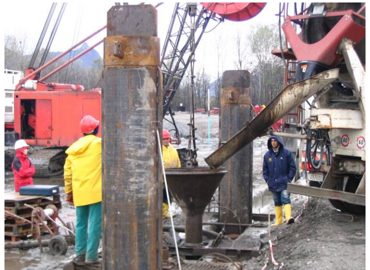
Figuur 6.4 IJzerscherm aanbrengen met diepwandtechnieken Turijn 2004 (Bron: ETI en NTP Milieu)
