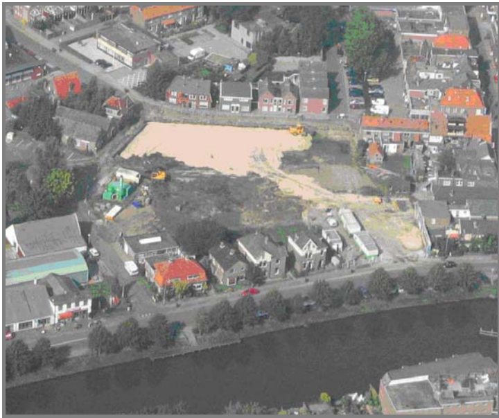
Afbeelding 1.3: Luchtfoto van het BOGAS-terrein na de grondsanering
