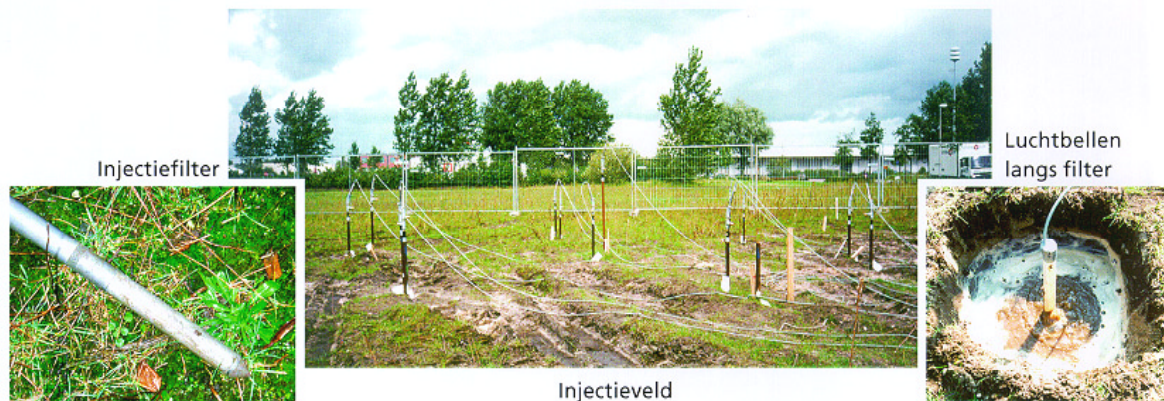
Fig. 16. Persluchtinjectieproef met weggedrukte injectie- en monitoringsfilters. Rechts 'foutieve monitoring' met behulp van een conventionele peilbuis.
