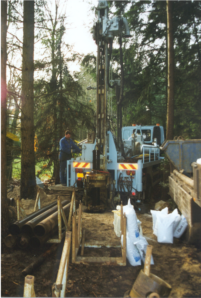
Figuur 11: Pulsboring te Austerlitz
