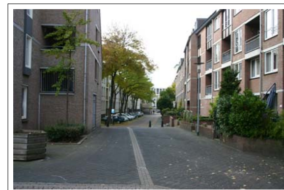
Foto 1: St. Teunisstraat vanuit het oosten
