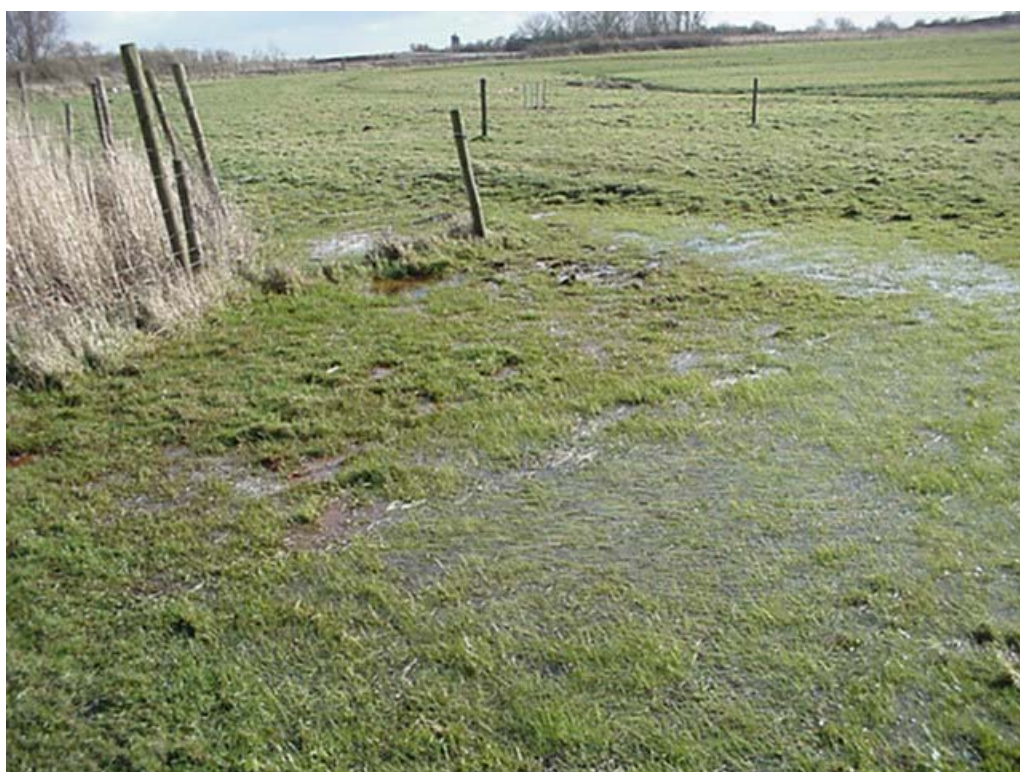
Fig. 5. Foto van water op het maaiveld onder aan het talud in de meetraai. Dit vormt een aanwijzing dat het freatisch peil (soms) boven het maaiveld uitstijgt.
