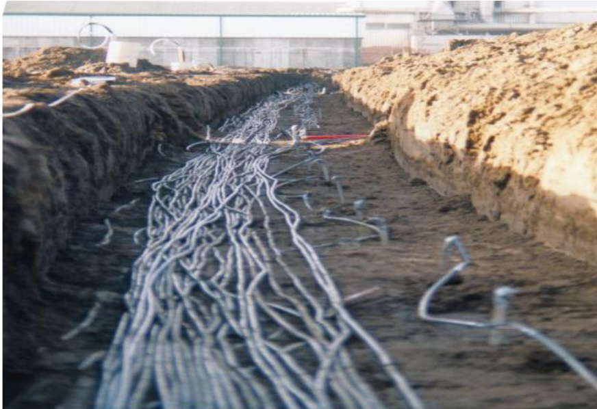
Fig. 9. Aanleg van de permanente geo-elektrische meetlijnen.
