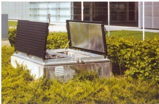
Figuur 5.1 Voorbeeld putbehuizing hogetemperatuuropslag
